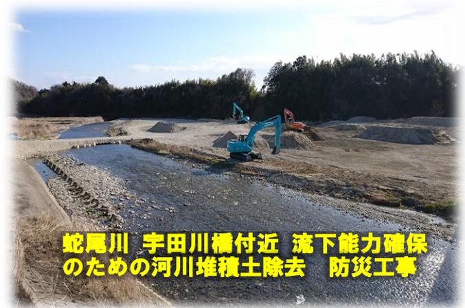
蛇尾川 宇田川橋付近 流下能力確保のための河川堆積土除去 防災工事
