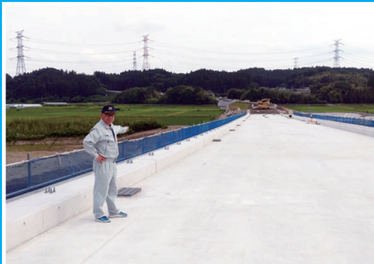
親園佐久山バイパス・令和7年度開通に向けて橋梁工事が進んでいます。更にライスラインから北への延伸を要望し調整を進めてまいります。
